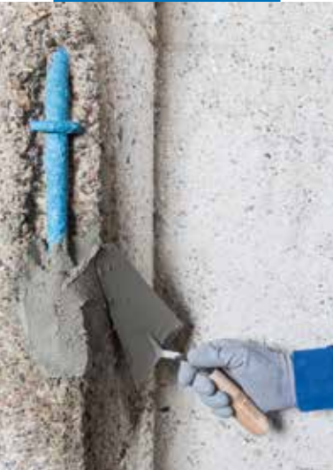
Aplicare Planitop Rasa & Ripara R4 cu mistria
