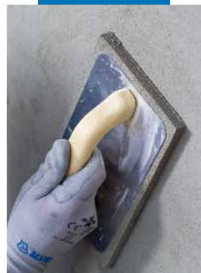
Drișuirea mortarului Planitop Rasa & Ripara R4
