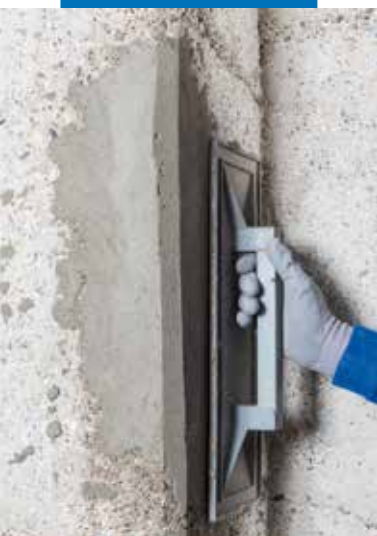
Lisarea suprafeței de Planitop Rasa & Ripara R4 pentru crearea unei suprafețe netede
