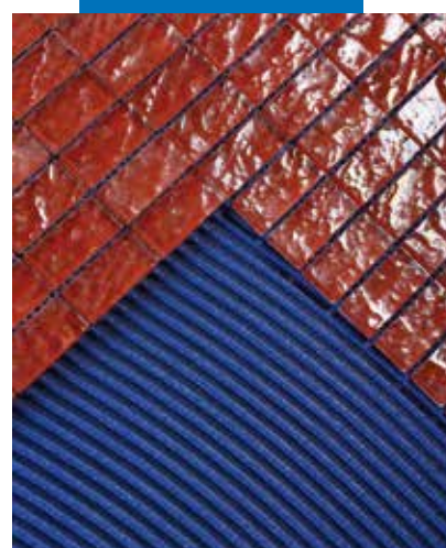
În ziua următoare, se chituiește cu aceeași culoare de Kerapoxy Design și în același mod, arătat anterior
